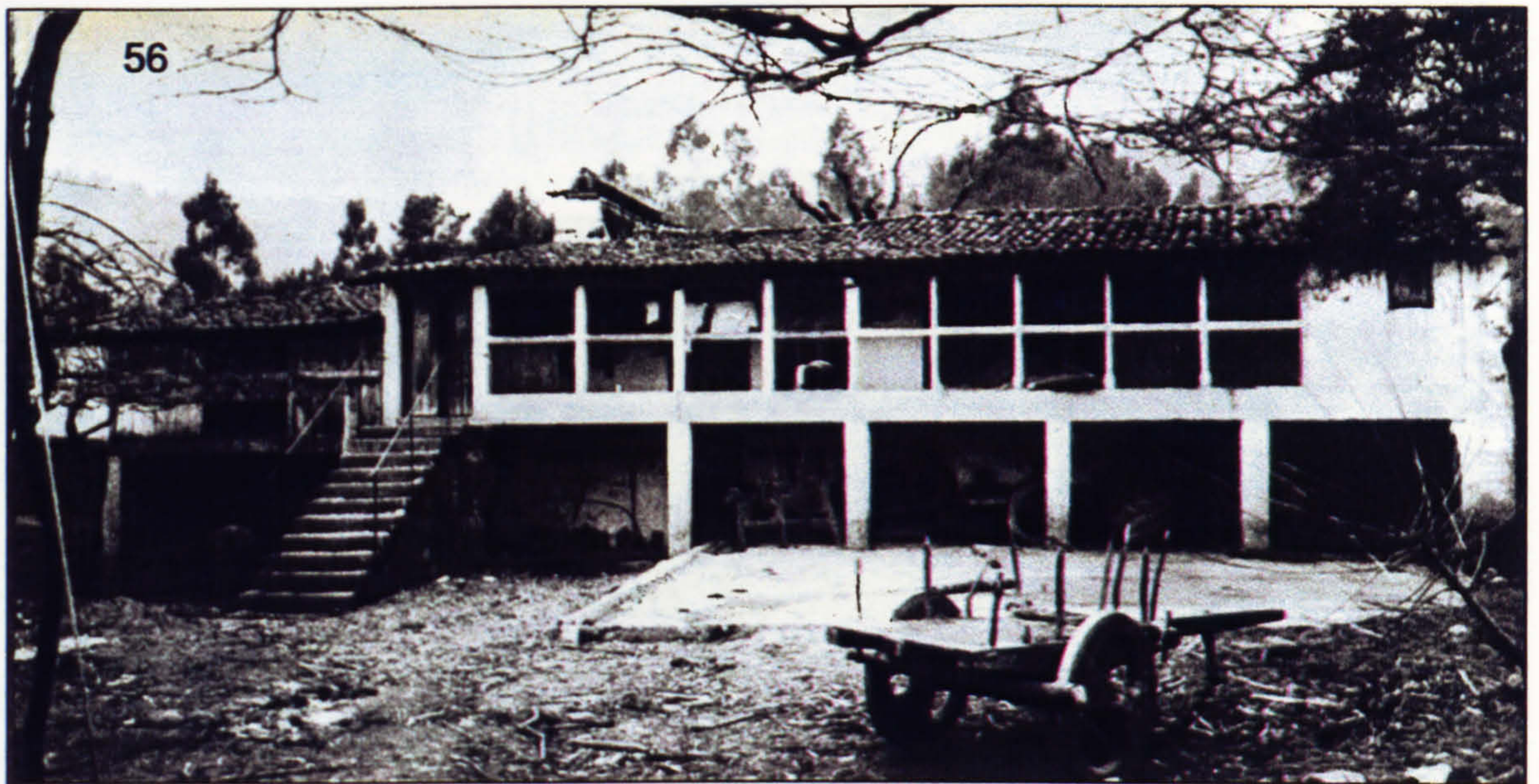
Plates 56– Farm house/”sequeiro”, Barcelos, Cremoxil, place of Sobreira (Z1 Data Sheet 24); 57- “Sequeiro”, Guimarães; 58- farm house/”sequeiro”, with “espigueiro” (corn barn) Barcelos, Encorados (Z1 Data Sheet 27); 59-“espigueiro”, Póvoa do Lanhoso, Soajo (Z1 Data Sheet 32); 60- farm house, Gramosa, Barcelos (Z1 Data Sheet 26).
